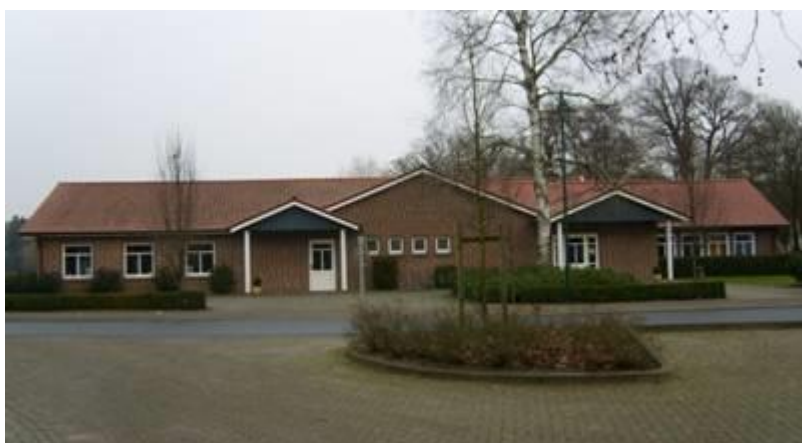
Das Gemeindehaus während der Bauarbeiten und nach der Fertigstellung.
