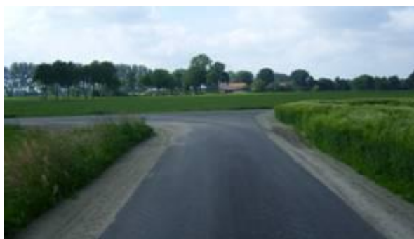
.... und nach der Erneuerung
